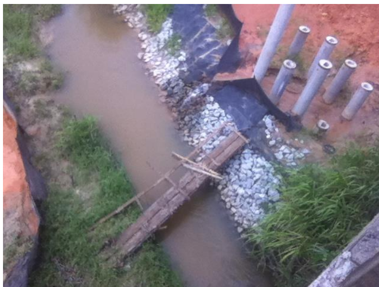
Figura 29: Vista aérea do ponto 3 e a obra de duplicação da BR101.
