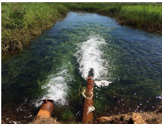
Figura 76: Água bombeada da vala de irrigação para o rio São João.
